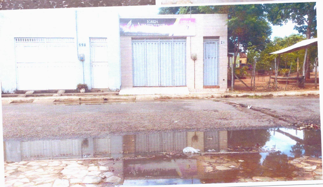
Rua João Davi de Oliveira Bairro Bico da Arara
